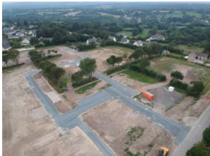
Photo du chantier mi-août
