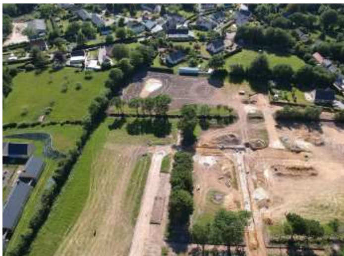
Photo du chantier mi-juin
